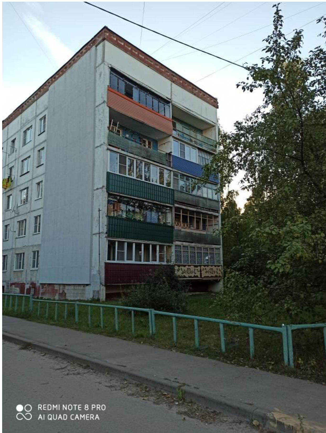
Фото 4.2. Фасад здания по оси V до обрушения. Фото предоставлено Заказчиком.
