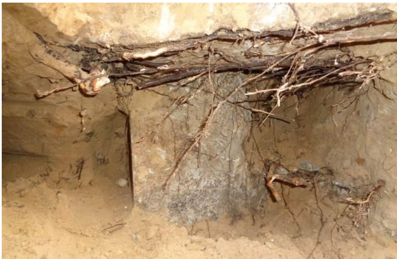
Фото 4.15. Свая фундамента в осях I/Г.
