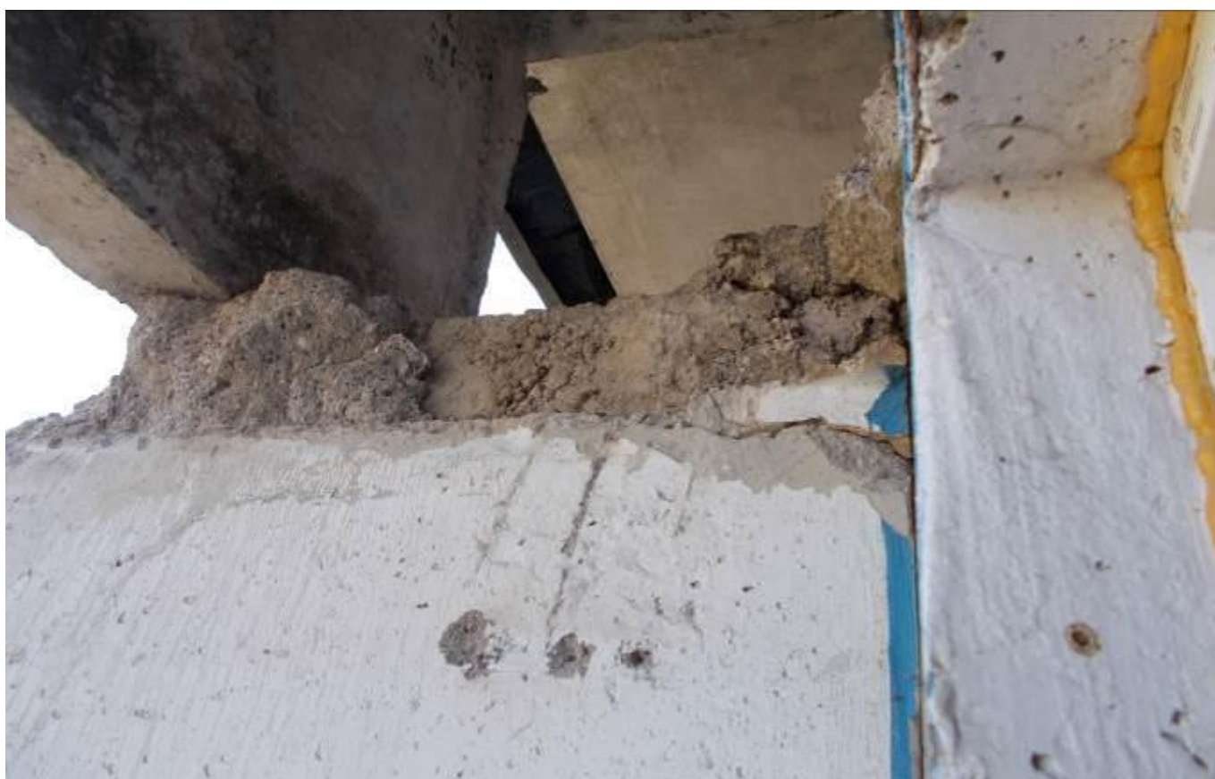
Фото 4.10. Площадка опирания плиты перекрытия лоджий в осях V/Б-Г на средней стене.
