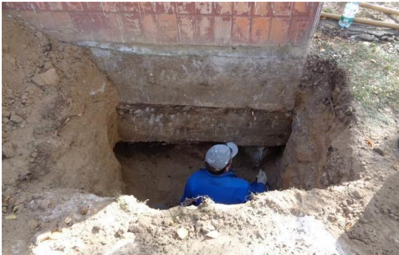
Фото 4.14. Шурф в осях I/Г.
