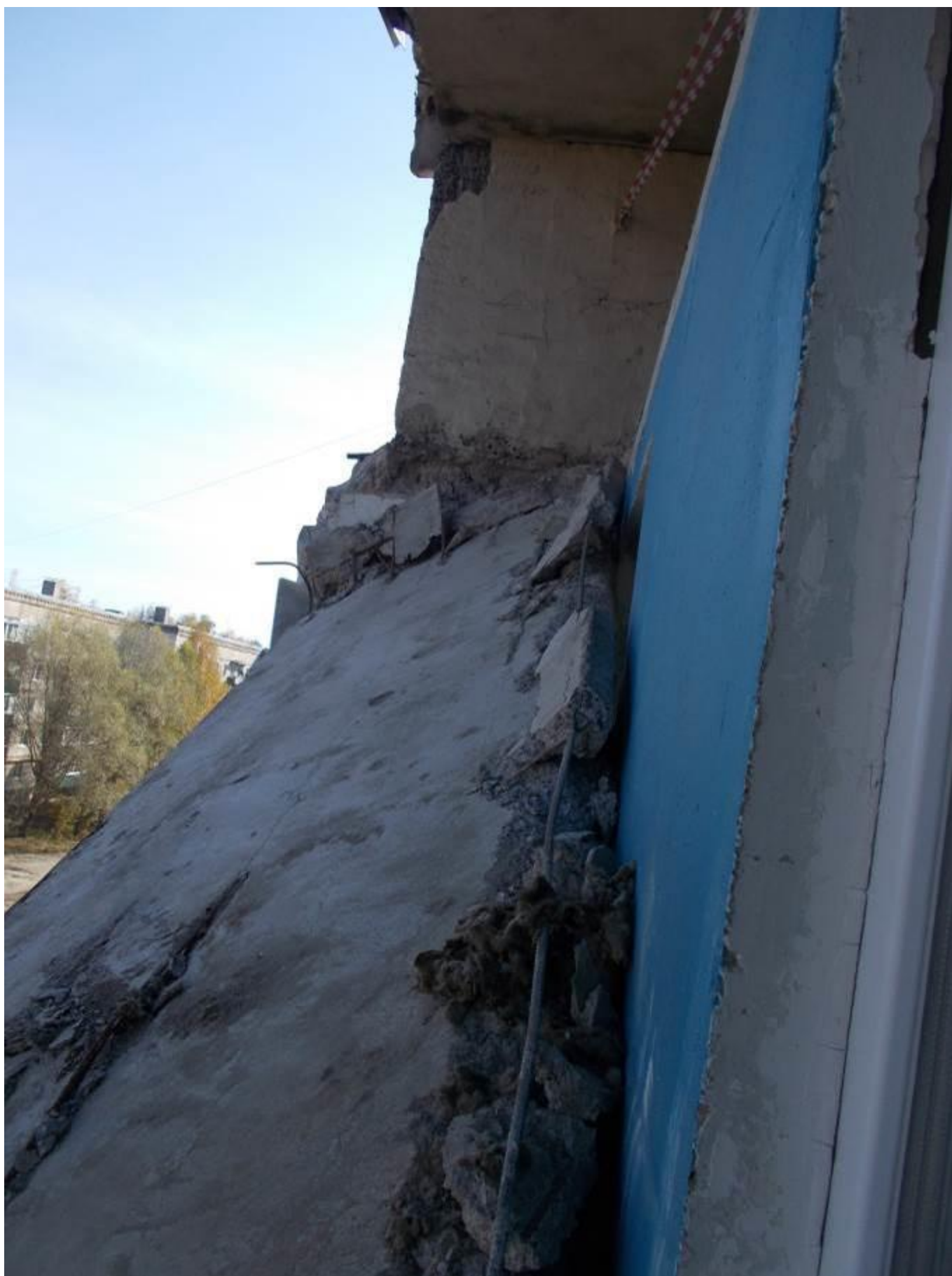
Фото 4.7. Плита перекрытия лоджий в осях V/A-Б.
