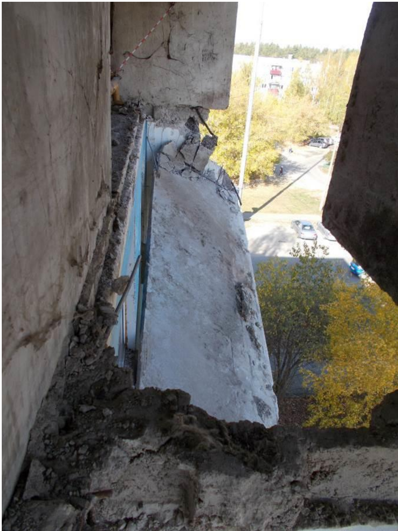
Фото 4.13. Плита перекрытия лоджий в осях V/Б-Г.
