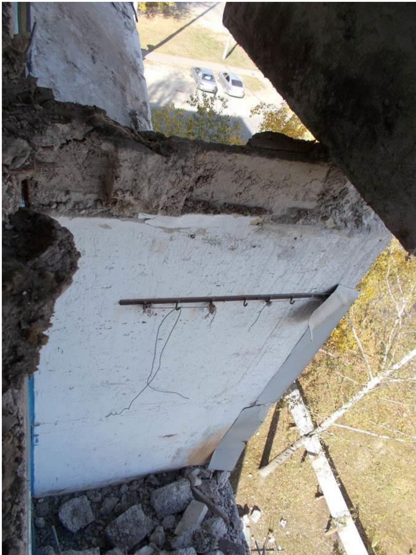
Фото 4.11. Площадка опирания плиты перекрытия лоджий в осях V/А-Б на средней стене.
