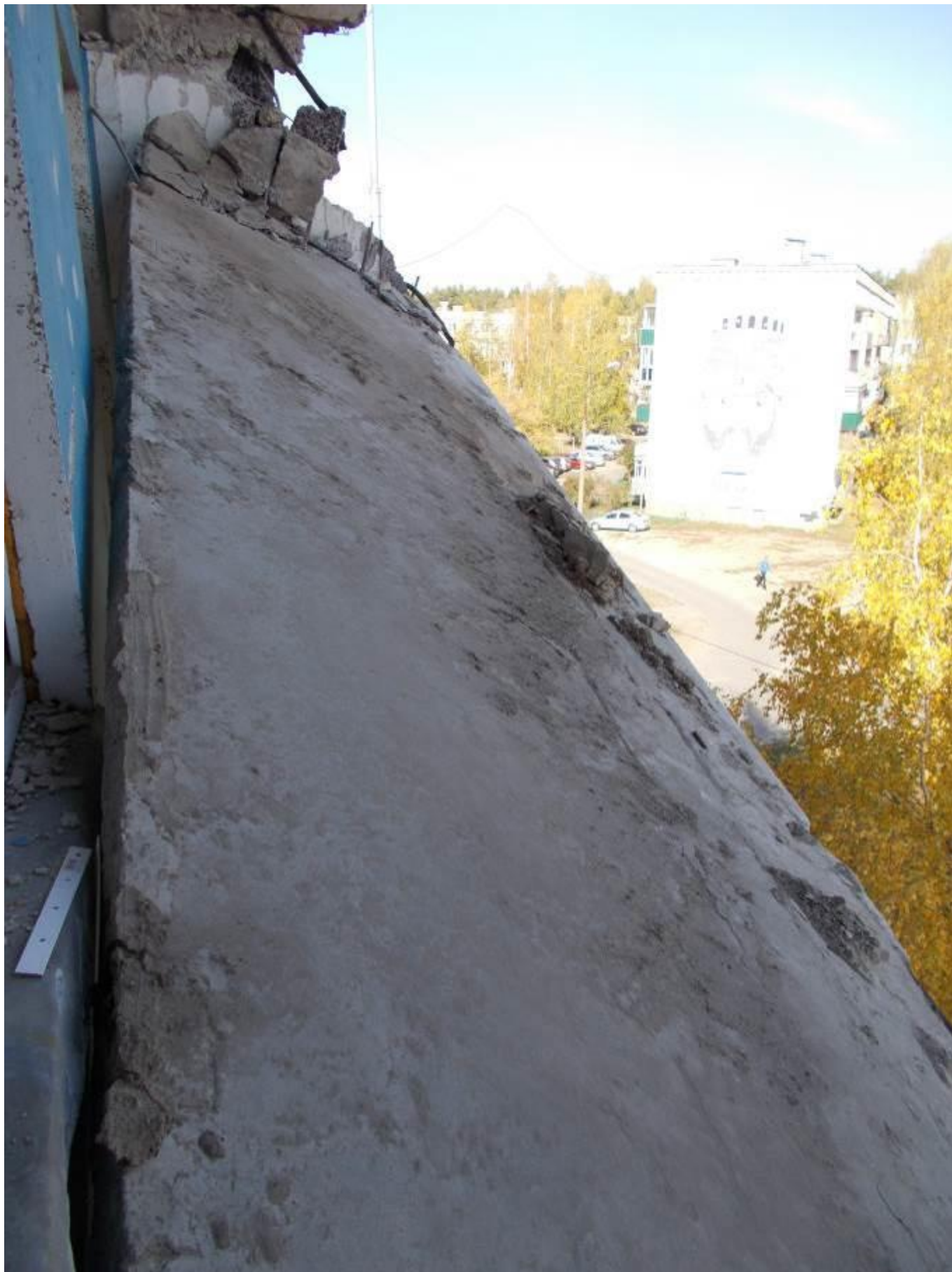
Фото 4.8. Плита перекрытия лоджий в осях V/Б-Г.
