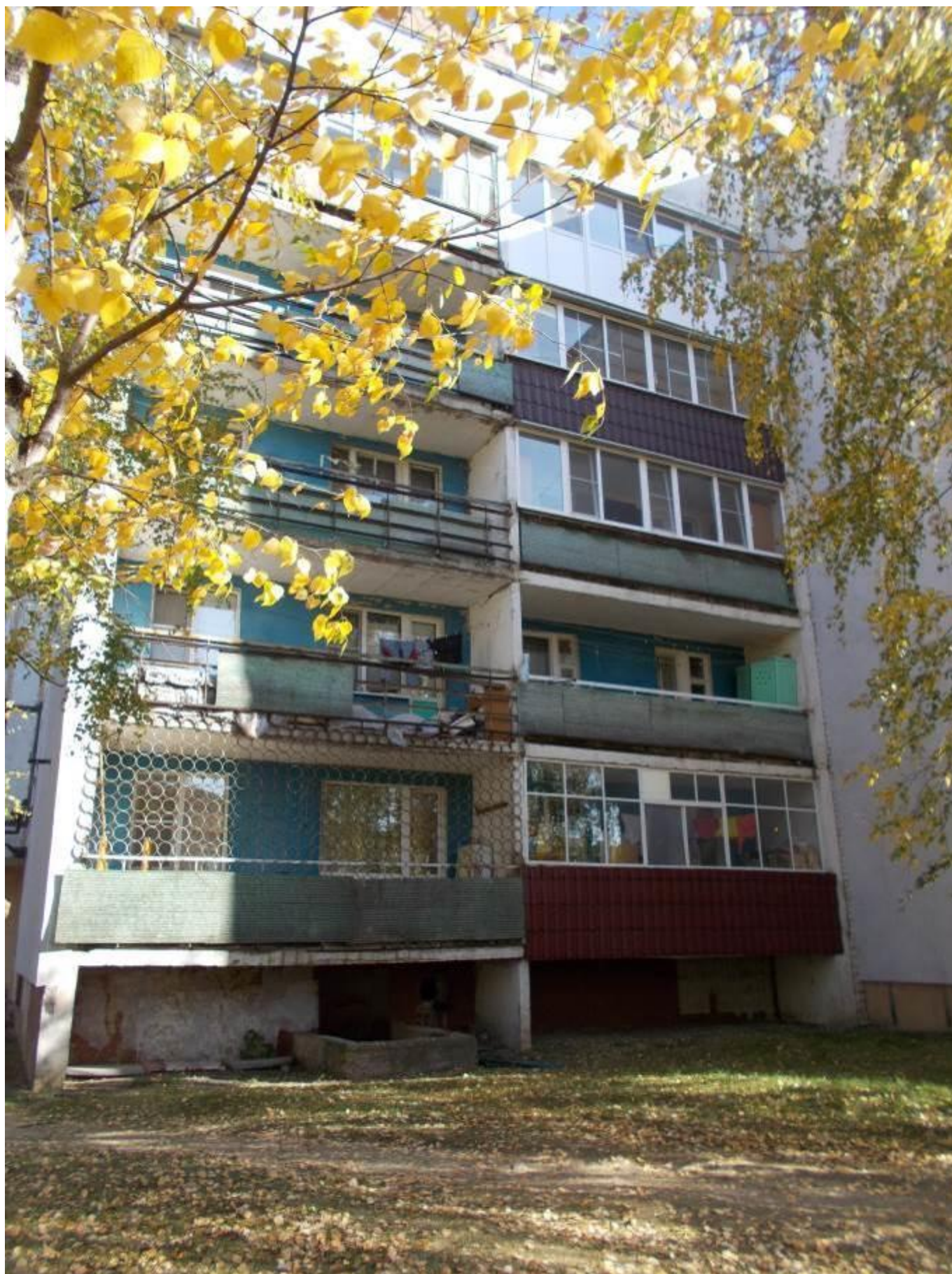
Фото 4.5. Фасад здания в осях I/Г-А. Вид с западной стороны.
