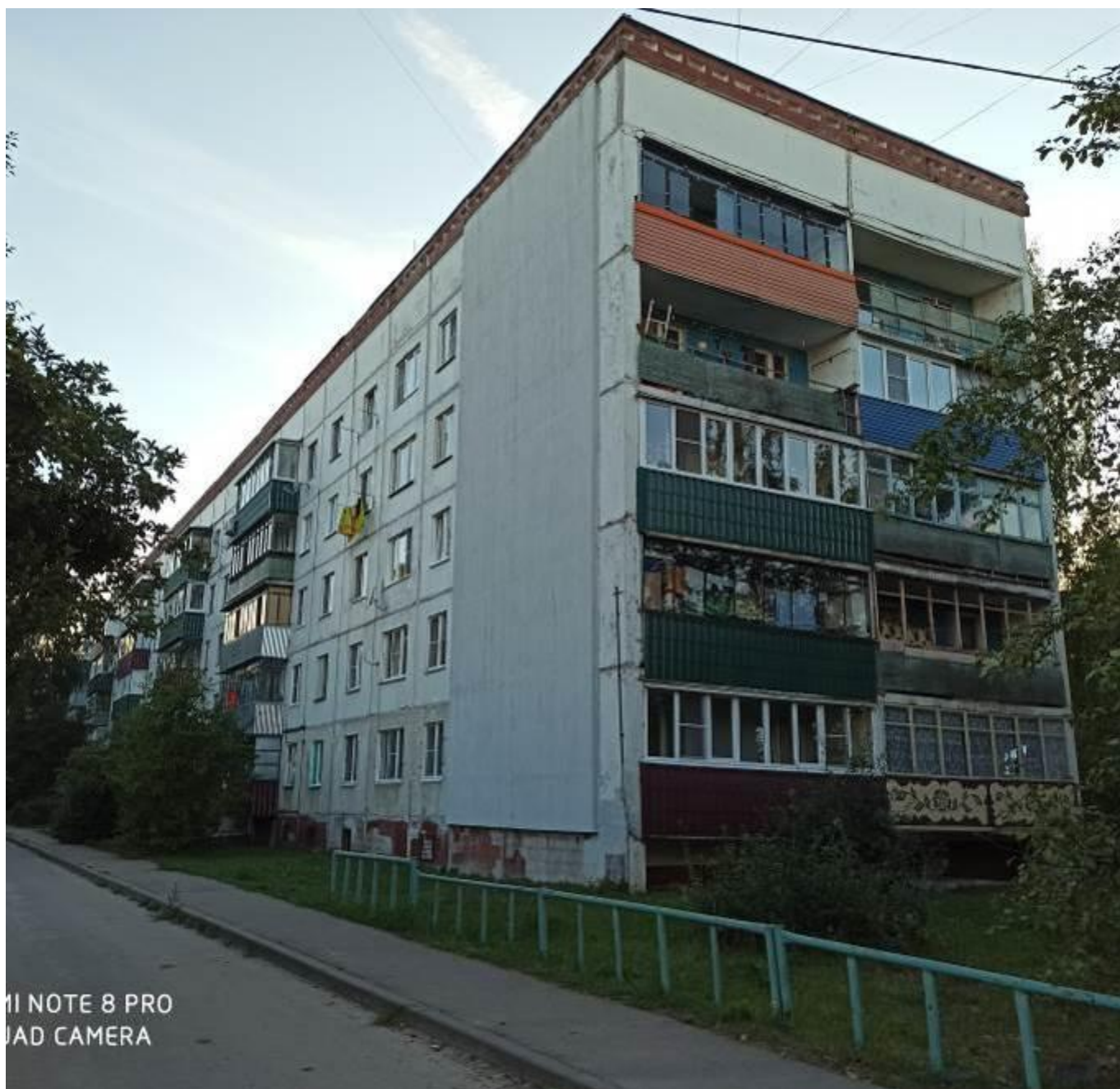
Фото 4.1. Фасад здания по оси V до обрушения. Фото предоставлено Заказчиком.
