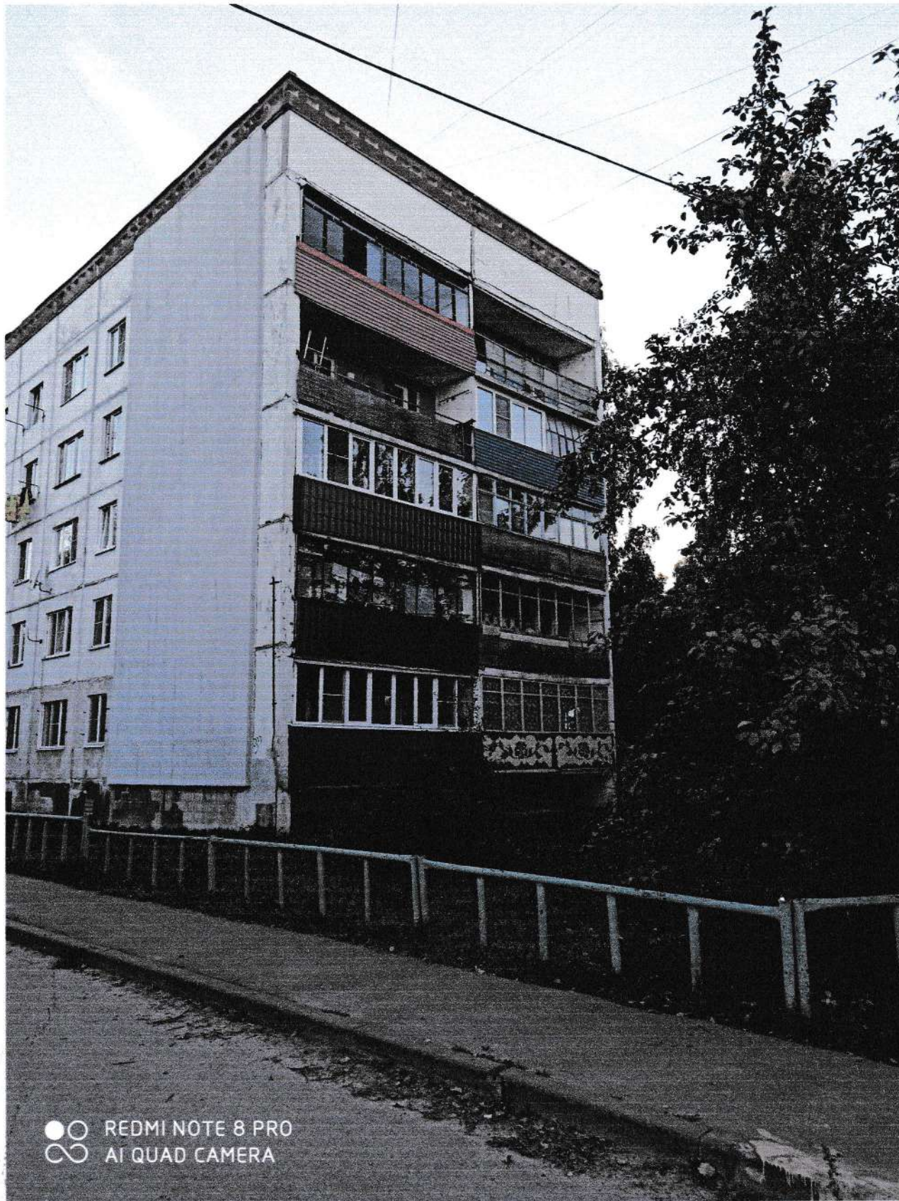
Фото 2. Вид жилого дома №ба м-на Жуковского в г. Выкса Нижегородской области. Здание 5-ти этажное, панельное
