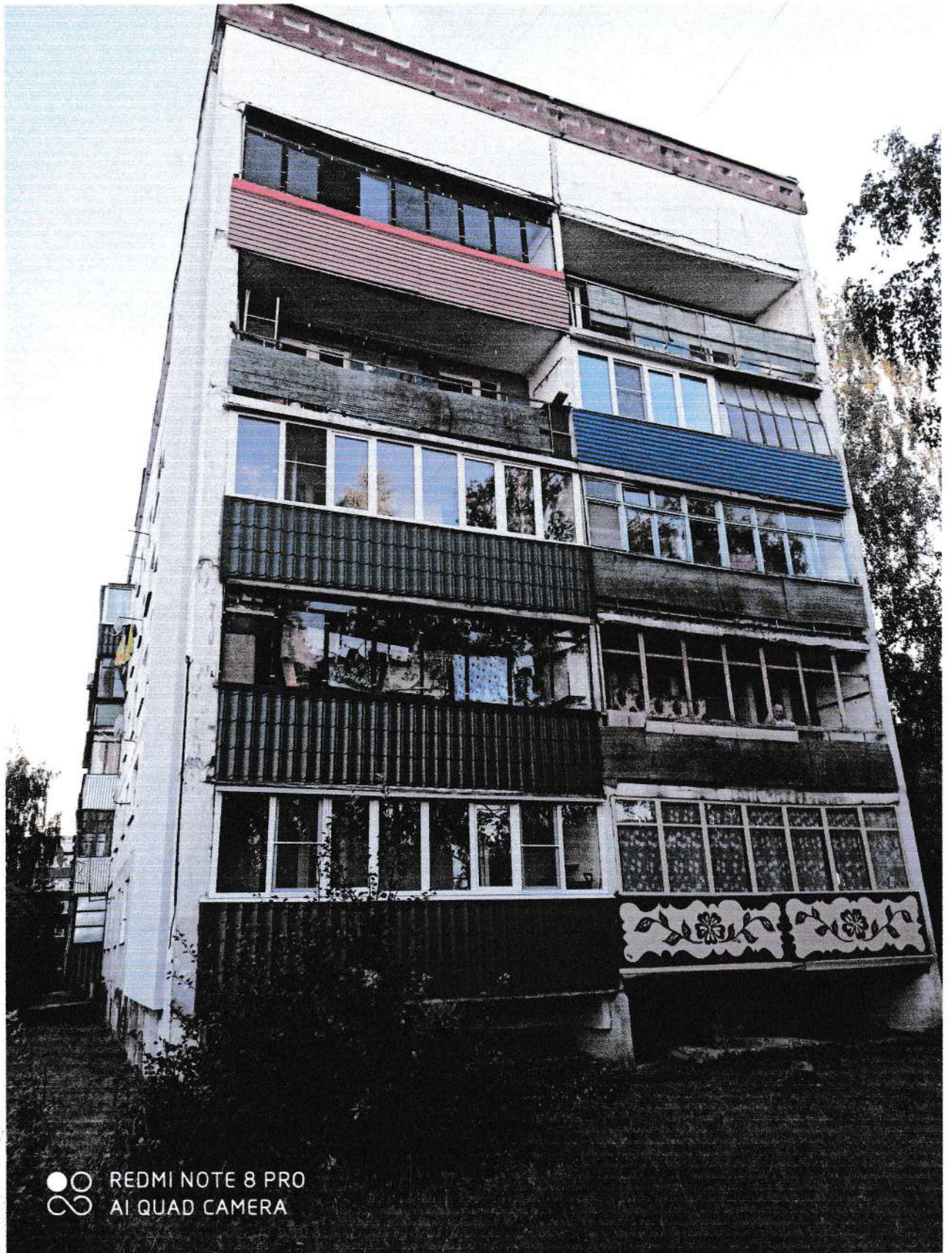
Фото 3. Вид жилого дома №ба м-на Жуковского в г. Выкса Нижегородской области. Здание 5-ти этажное, панельное
