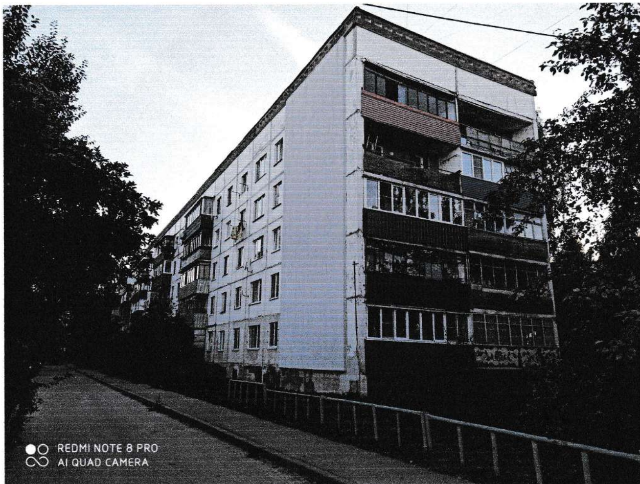
Фото 1. Вид жилого дома №ба м-на Жуковского в г. Выкса Нижегородской области. Здание 5-ти этажное, панельное
